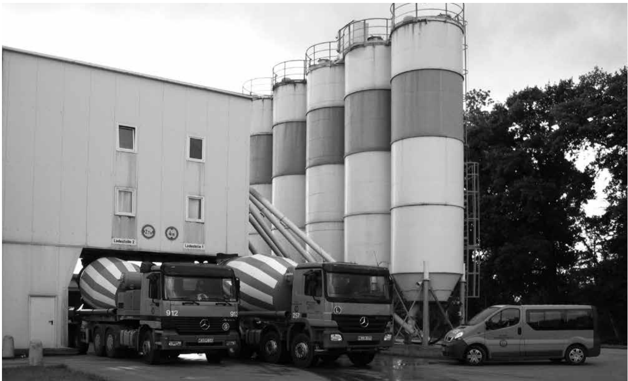
Bild 1: Lieferung von Transportbeton mit dem Fahrmischer
